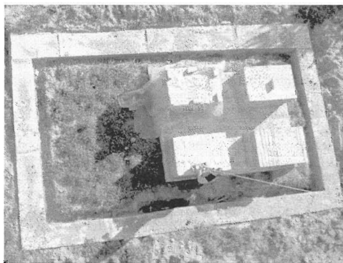
Рис. 2. Независимое расположение фундаментов под стены и постаменты для датчиков
